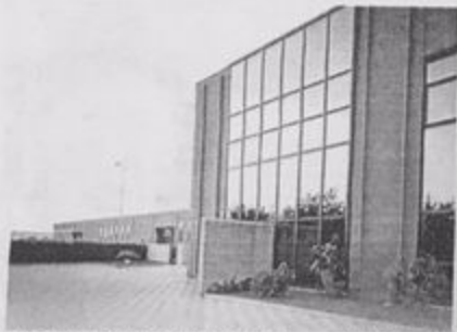
L'impianto di via Cavin di Sala della Bovo Bags
